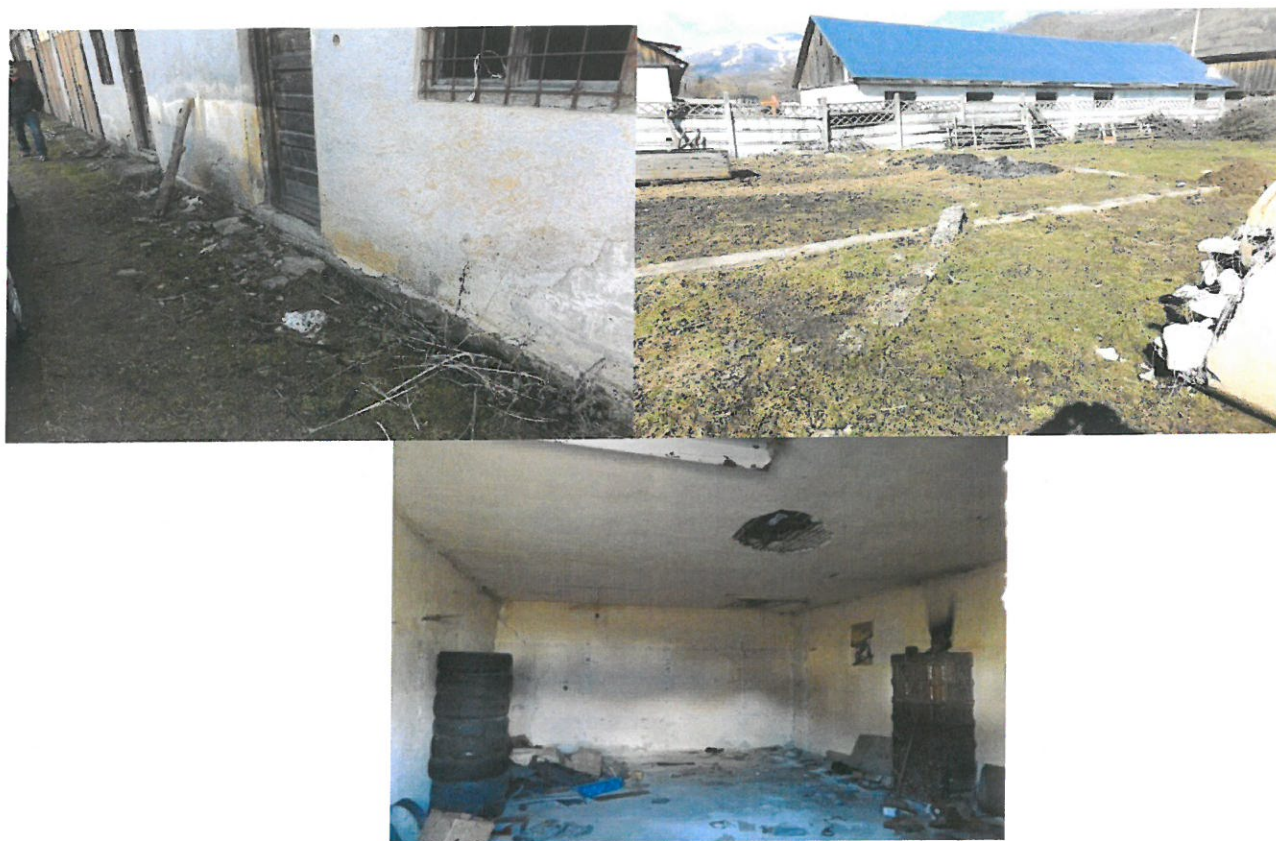
Foto stânga: construcție existent pe amplasament / foto dreapta: curte existentă
