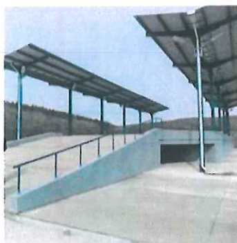
Figură 4-1 Stație de transfer
