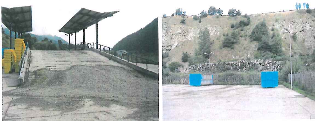
Figura 2-17 – Stația de transfer și Centrul de colectare Sângeorz-Băi
