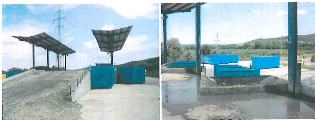
Figură 2-8 Stația de transfer și Centrul de colectare Beclean
